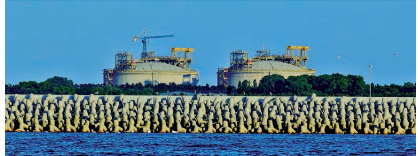
Fot. Część lądowa terminalu LNG.
