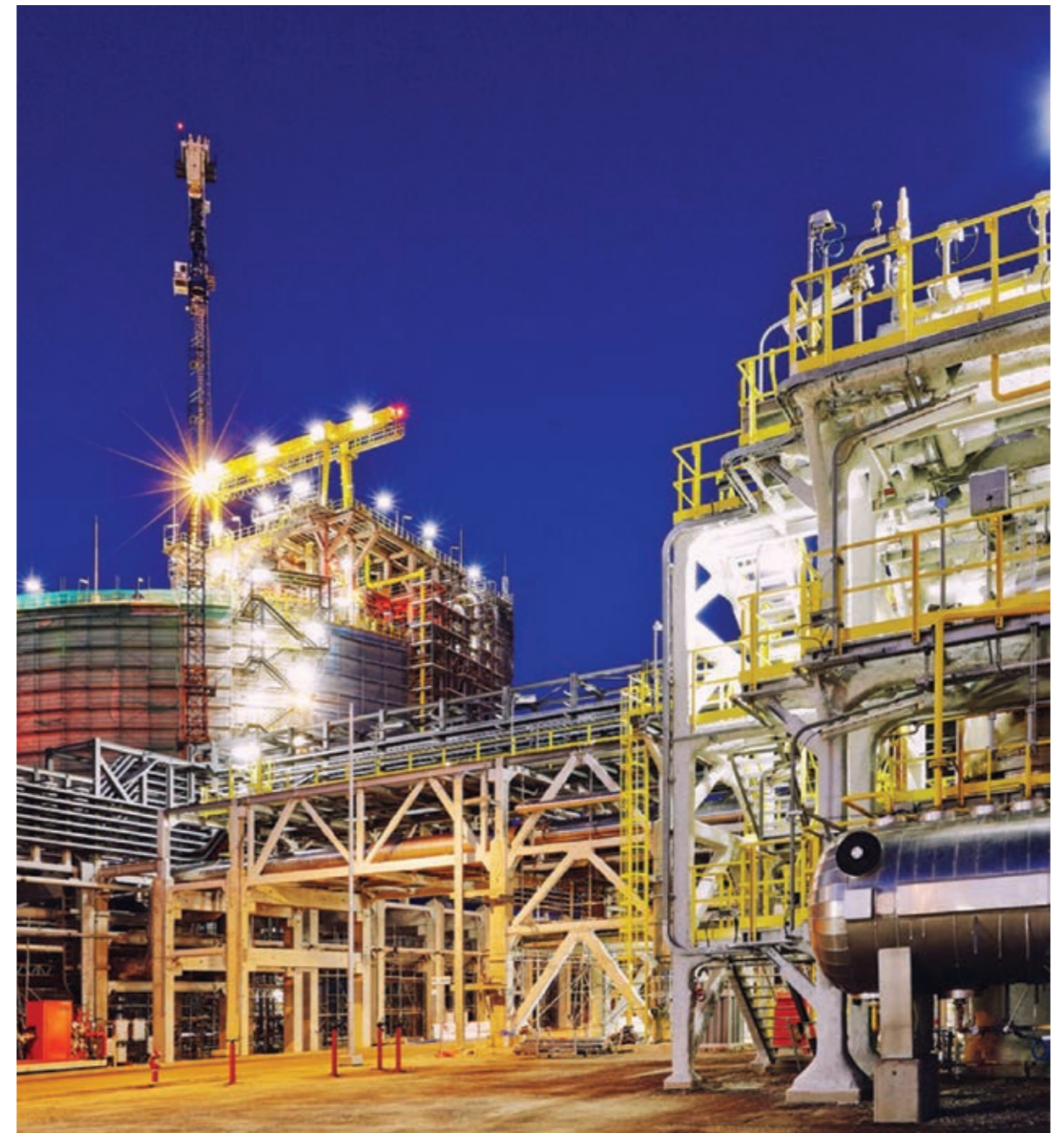
Fot. Terminal LNG w Świnoujściu.
